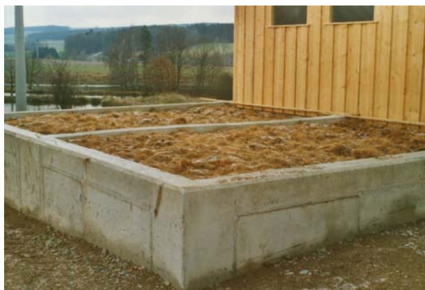
Bild 6: ein Biofilter sorgt für gute Luft
