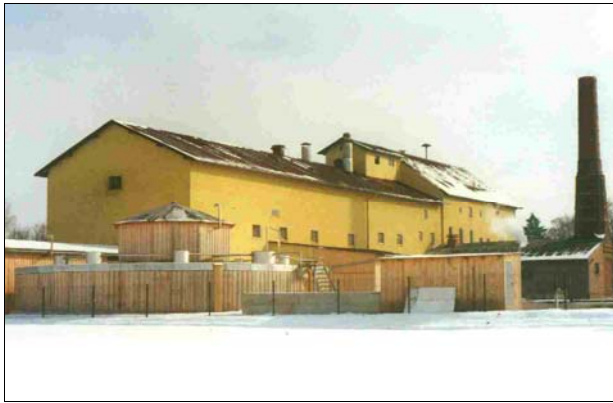
Abbildung 6 - Biogasanlage Brennerei und Trocknerei Altheim
